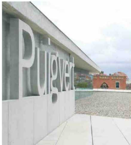
Detalle de la fachada de la Fundació Puigvert en Barcelona. FACEBOOK
